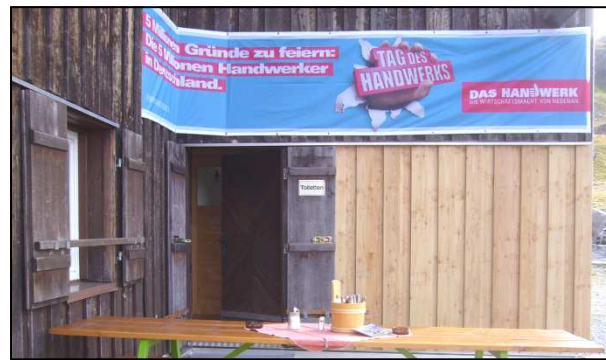
Die Musterwand mit österreichischer Lärche. Bis 2014 soll die ganze Hütte so aussehen.
